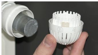
Beispiel: Bringen Sie den Begrenzer rechts von der Nummer 3 an. Dadurch kann der Knopf vollständig geschlossen oder bis Position 3 geöffnet werden.
