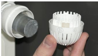
Exempel: Montera begränsaren till höger om siffran **3**. Detta gör att vredet kan vara helt stängt, eller öppnas så långt som till position **3**.
