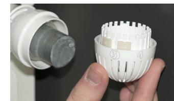
4. Nachdem die Begrenzer positioniert sind, bringen Sie den Knopf durch geeigneten Druck in die initiale Einstellungsposition (3).
